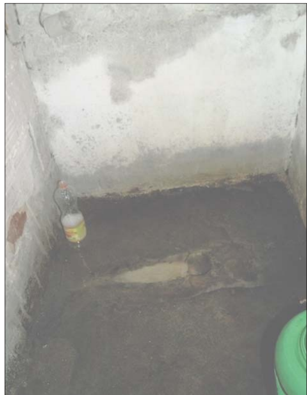
Dusche und Toilette in einem Haus in Strumica
